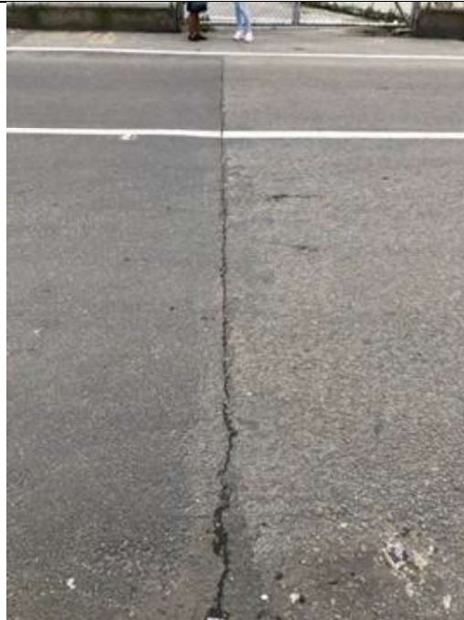
Junta de dilatación, ambos extremos, sin sello Fisura transversal
