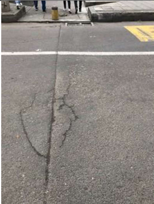
Junta de dilatación, ambos extremos, sin sello Fisura transversal
