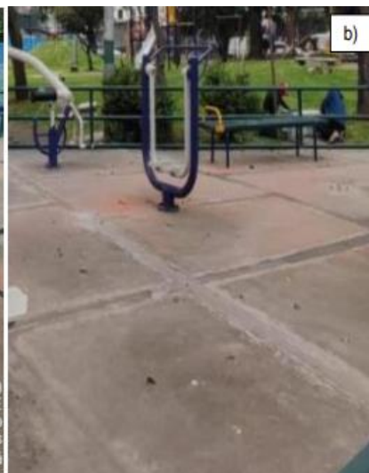
Imagen 2. Se observó ausencia de dilatación correcta entre la cancha y el bordillo de confinamiento.
