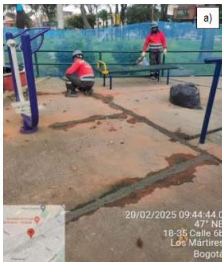
Imagen 1. Se observó ausencia de dilatación correcta entre la cancha y el bordillo de confinamiento.
