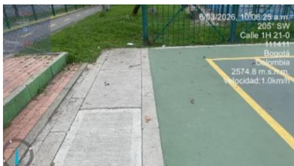
Imagen 1. Se observó ausencia de dilatación correcta entre la cancha y el bordillo de confinamiento.
