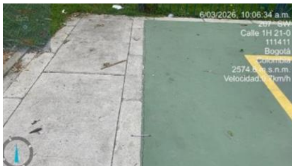
Imagen 2. Se observó ausencia de dilatación correcta entre la cancha y el bordillo de confinamiento.
