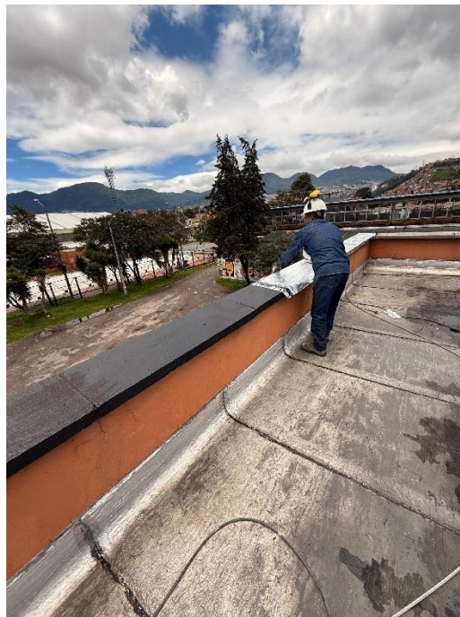
Figura No. 13. Intervención y Mejoramiento de Sede Alcaldía Local de Rafael Uribe Uribe
